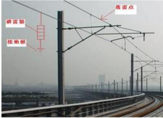
图 1-1 接触网避雷器示意图
